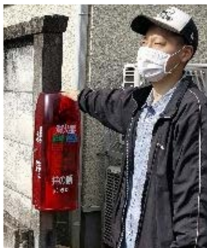
消火器の設置場所を確認！
